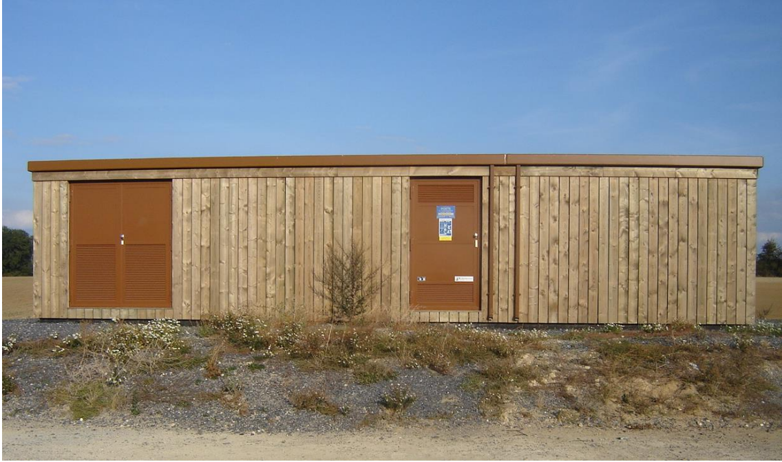
Figure 4 : exemple de postes de livraison en bardage bois
